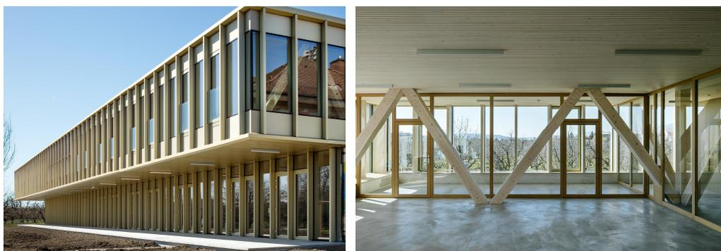
Die Erweiterung des Schulhauses in Sutz-Lattrigen liegt weitgehend auf einem bestehenden Untergeschoss. Somit konnten die Lasten des zweigeschossigen Gebäudes, das auf eine vollflächige Aufstockung um ein weiteres Geschoss ausgelegt ist, nur punktuell abgegeben werden. Daraus resultierte ein Tragwerkskonzept mit raumhohen Fachwerken, bestehend aus Brettschichtholzdiagonalen und Stahlgurten. Die Fachwerkgurte wurden in die Holz-Beton-Verbunddecken integriert.
