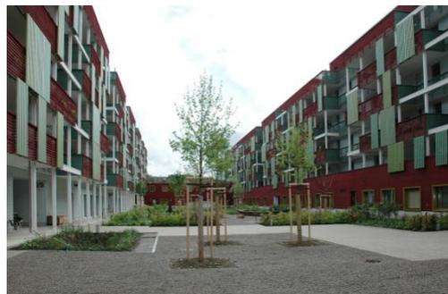
**Der sechsgeschossige Wohnbau im Minergie-P-Eco-Standard ist mit Ausnahme des Untergeschosses und der Treppenhauskerne in Holzbauweise erstellt.**
