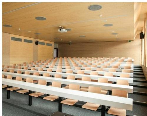
Die zwei viergeschossigen Gebäude sind durch zentrale Treppenhäuser aus Stahlbeton erschlossen. Als Geschossdecken dienen Hohlkastenelemente mit einer Abmessung von 1.8 x 8.0m, welche mittels Kalksplittschüttung in den Hohlräumen und Zementunterlagsboden den Schallschutz sicherstellen. Mit der perforierten Untersicht der Hohlkasten wird einfach und kostengünstig eine angenehme Raumakustik erreicht. Die Aussteifung der Gebäude erfolgt auf die Betonkerne, was eine sehr offene Fassade ermöglicht.
